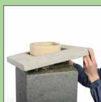
32. Встановити на розчин бетонну накривну плиту.
