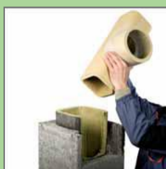
22. Приклеїти трійник (під'єднання печі).
