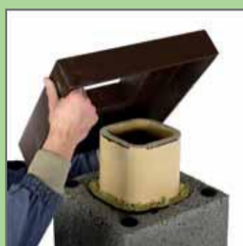
28. Покласти накривну цементно-волоконну плиту.
