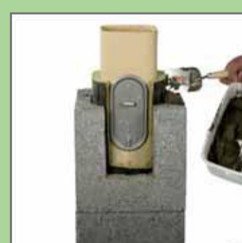
12. Накласти будівельний розчин на пустотілий блок.
