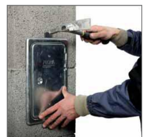
Зовнішні дверцяла прочистки кріпляться за допомогою покрівельних цвяхів.
