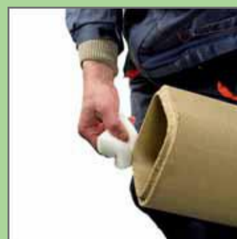
8. Очистити шпунтове з'єднання вологою губкою.
