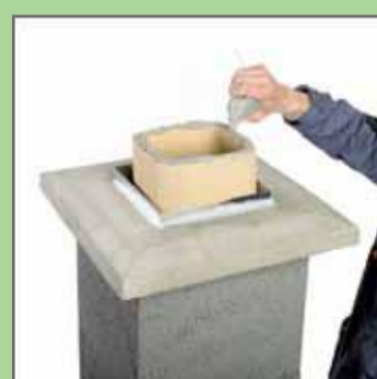
35. Накласти замазку на підрізану керамічну трубу.
