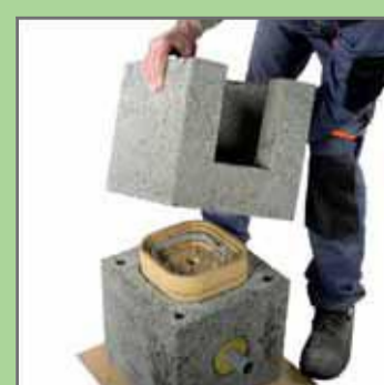
6. Встановити пустотілий блок з вирізаним отвором для дверцят (16x31 см).
