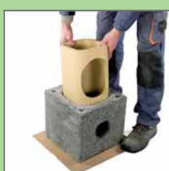
1. На шар ізоляції встановити пустотілий блок з вирізаним отвором для відведення конденсату, встановити в ньому цокольную трубу.
