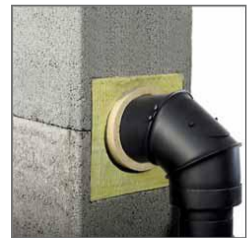
Приклад правильного під'єднання в місці проходу через дах із застосуванням редукції. (Тимчасове під'єднання виконувати таким же способом).
