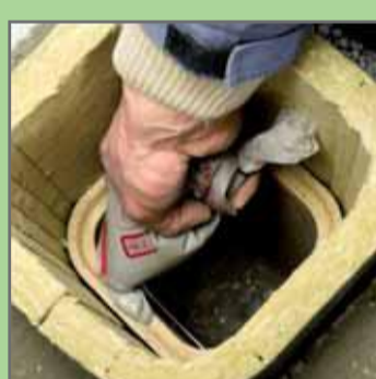
16. Накласти кислотостійку замазку.
