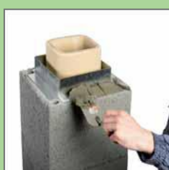
31. Встановити незнімну опалубку, накласти будівельний розчин.
