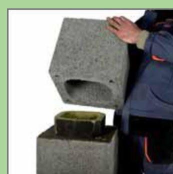
15. Розмістити на розчині наступний пустотілий блок.
