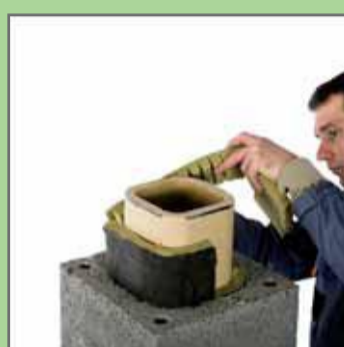
25. Відрізати надмір волокна за останнім пустотілим блоком.
