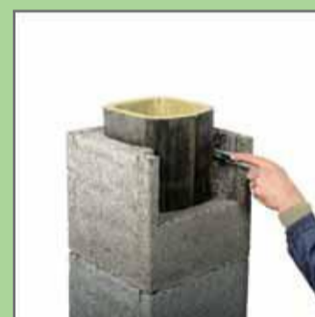
21. Підрізати волокно до підготованого отвору.
