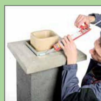
33. Ущільнити покрівельним силіконом простір між «комір» опалубки та плитою.
