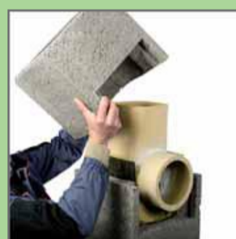
23. Посадити пустотілий блок з наступною частиною вирізу на розчин.
